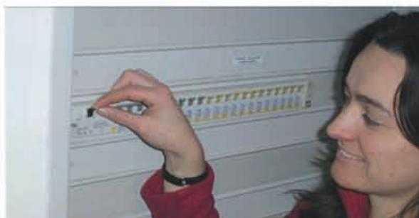
Alle Fehlerstromschutzschalter sind mit einer Prüftaste ausgestattet, die einen Funktionstest erlaubt. Wird die Prüfung nicht durchgeführt, können die Kontakte verkleben. Ein Auslösen im Fehlerfall ist dann nicht möglich.
